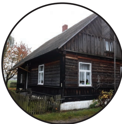
budynek przeznaczony do rozbórki
