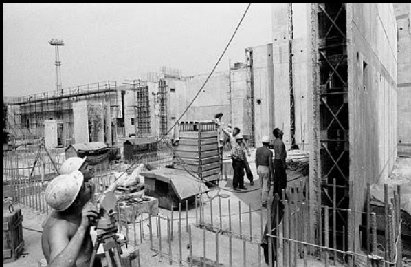
FIG. 4. ELEKTROWNIA ŻARNOWIEC W BUDOWIE
