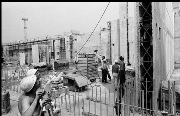
FIG.4. ELEKTROWNIA ŻARNOWIEC W BUDOWIE
