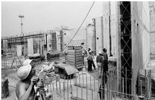
FIG.2. ELEKTROWNIA ŻARNOWIEC W BUDOWIE
