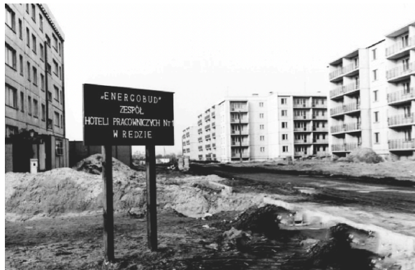
FIG.3. OSIEDLE ENERGOBUD W BUDOWIE
